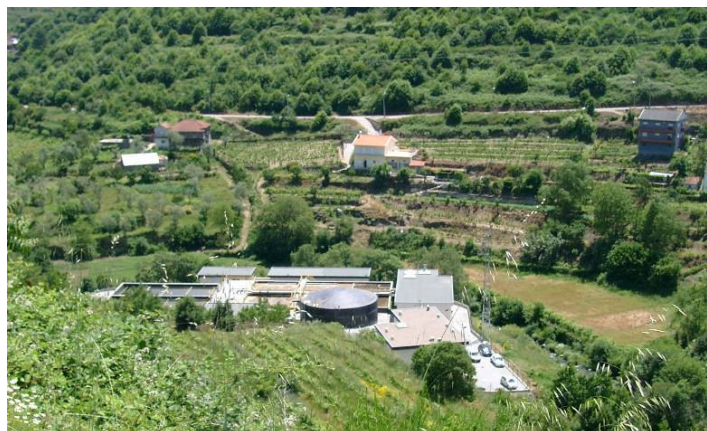
Figura VI.32. Estação de Tratamento de Águas Residuais de Lamego
