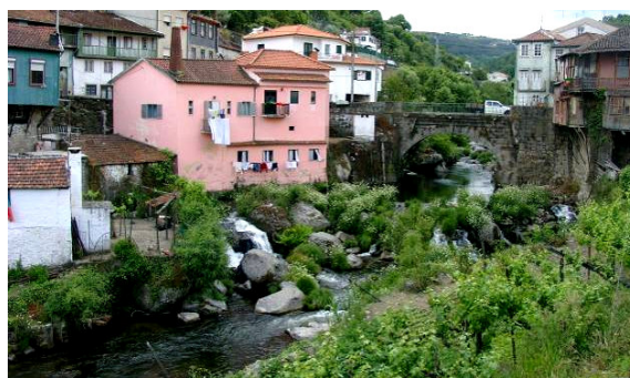
Figura VI.10. Rio Balsemão no Bairro da Ponte
