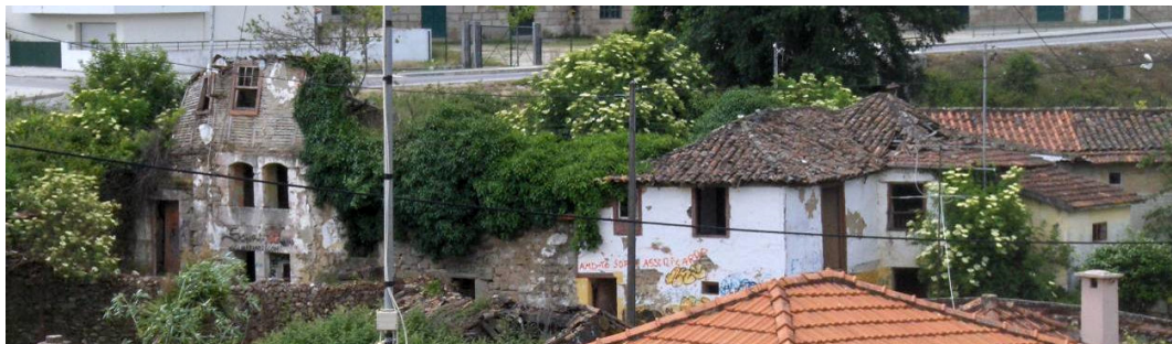
Figura VI.28. Edificações existentes no local de construção do Parque Urbano
