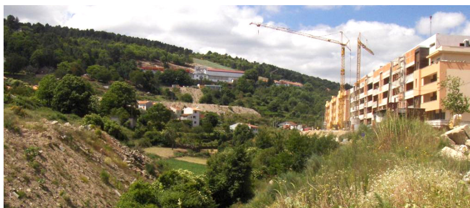
Figura VI.29. Construção na margem da Ribeira do Coure
