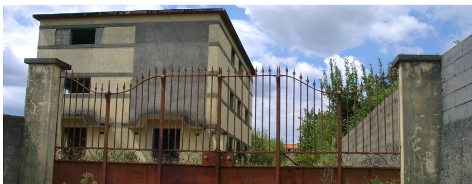
Figura VI.15. Parte das instalações das antigas suiniculturas
